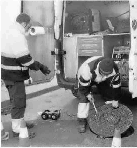
JUAN CARLOS MUÑOZ Dos operarios trabajando en el alcantarillado de Coria en noviembre de 2017.
