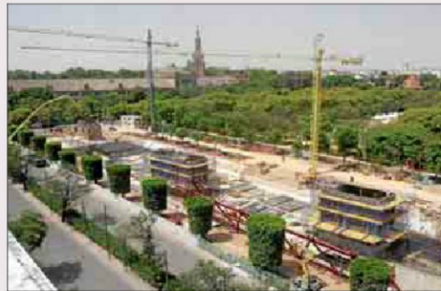
16 de junio 2009. Estado de las obras al ser declaradas ilegales. / C. M.
