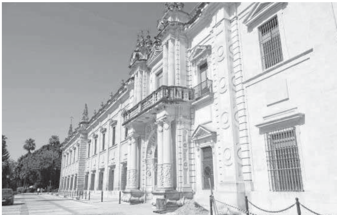
La Hispalense detalla que ha rehabilitado cerca de un 50% de la fachada del Rectorado.
