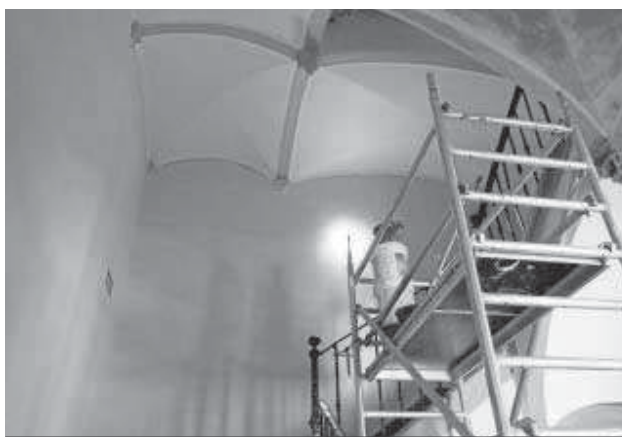
Trabajos de conservación en las bóvedas del edificio levantado en el siglo XVIII.
