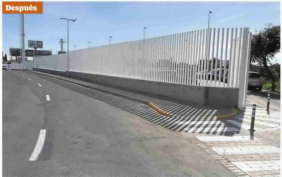
Estado de la calle Federico García Lorca, después de realizar la obra del aparcamiento y eliminar los árboles. / Sevilla Más Verde
