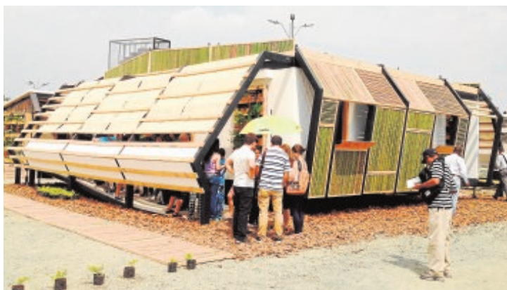
Fachada lateral de acceso a la vivienda social
