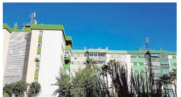
Antenas actuales, vistas desde el patio del colegio Los Guindos.
