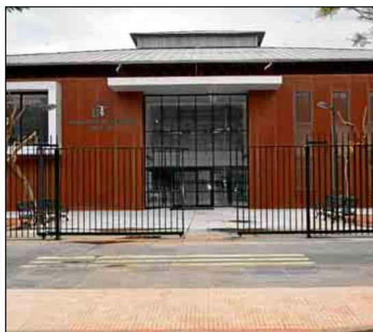
El SADUS sigue mejorando sus instalaciones cada temporada.
