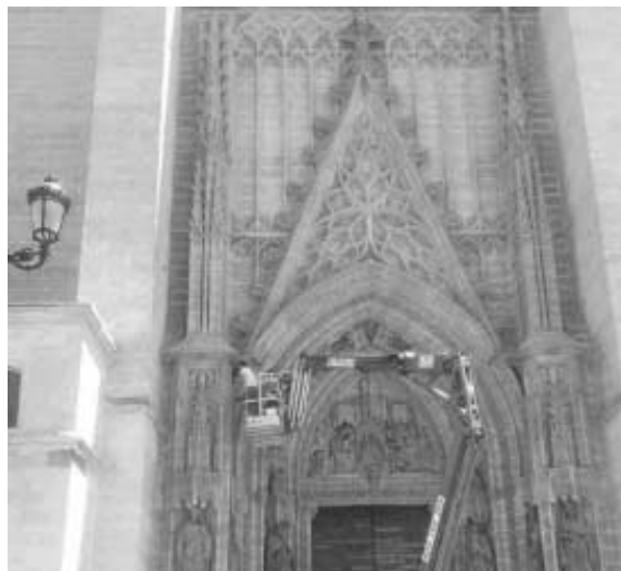
Rehabilitación en la Puerta de San Miguel de la Catedral, ayer.
