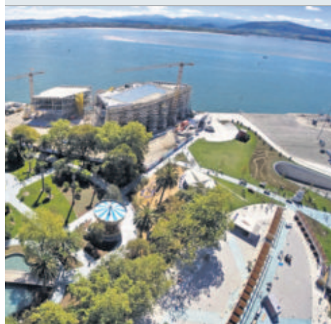
Aspecto actual de las obras del Centro Botín y de los adyacentes Jardines de Pereda.
