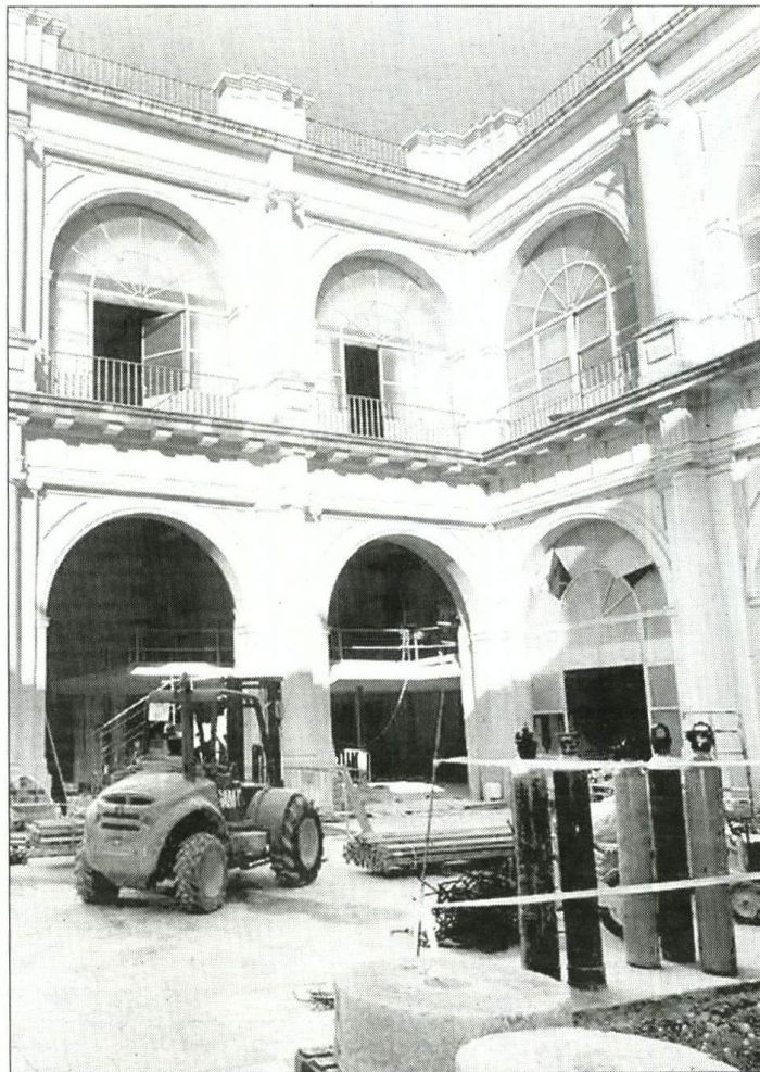
Obras en el edificio de la antigua fábrica de Tabacos en 2011. / EL CORREO
