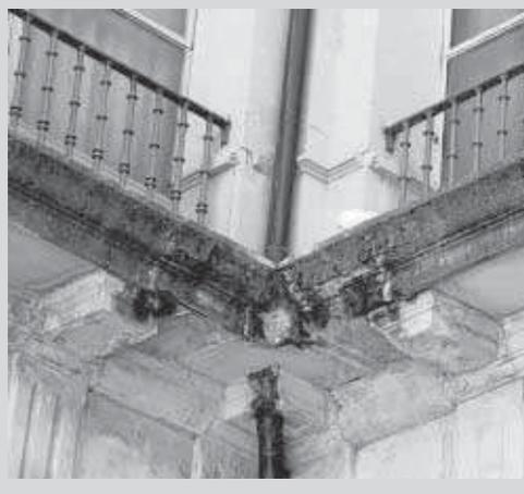
la existente), por lo que la selección del material deberá ser exhaustiva y siempre buscando el mayor parecido con el original. El sistema de fijación será el mismo, mediante anclajes tipo Hilti y varillas de acero inoxidable, de modo que se garantice el anclaje de la piedra al elemento soporte. Para la reintegración volumétrica se recurrirá a cualquier documento, gráfico o escrito, que aporte datos fidedignos del aspecto primitivo de la
