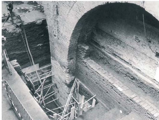
Las excavaciones de Amores mostraron la altura real de las naves de las Atarazanas. ARCHIVO
