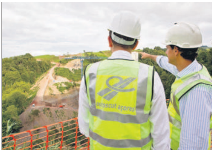
Ingenieros de Ferrovial en Portugal.
