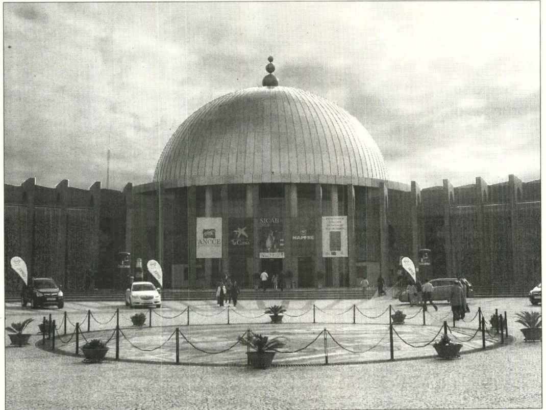
Edificio central de la parte antigua del Palacio de Congresos y Exposiciones de Sevilla. / SERGIO RIVAS
