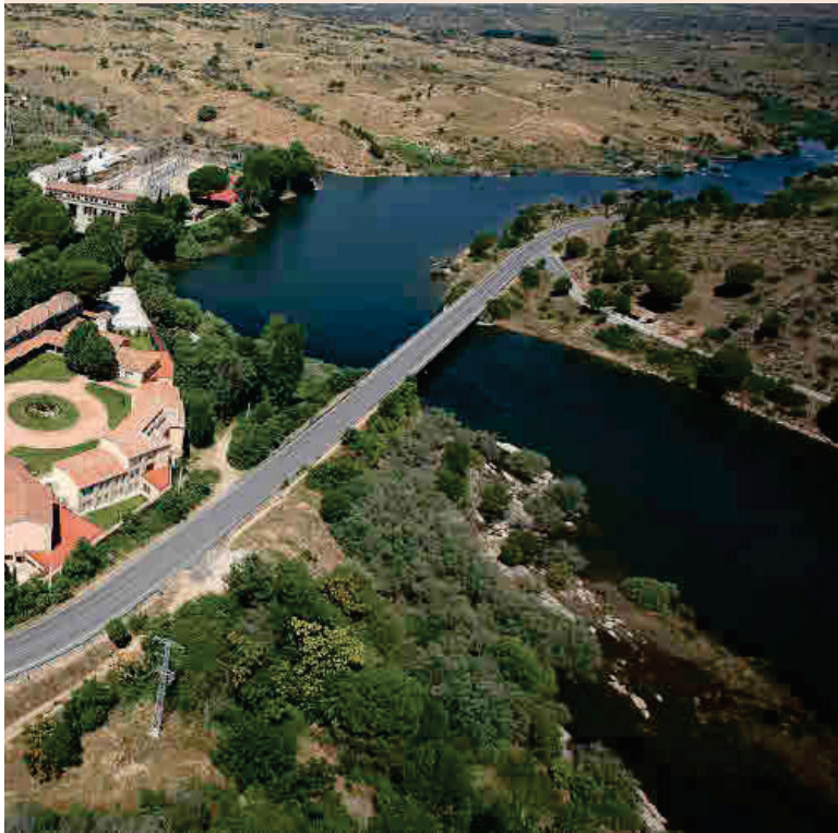
El campus de Gas Natural Fenosa se encuentra en Ávila.
