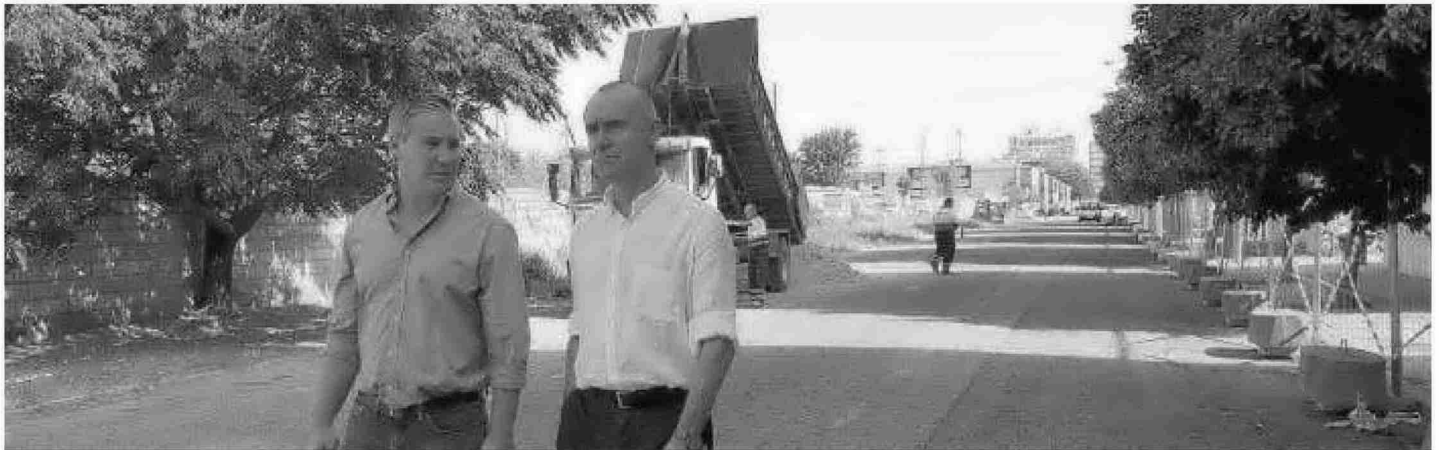
El delegado de Hábitat Urbano de visita a la obra iniciada en la calle Tarfia
