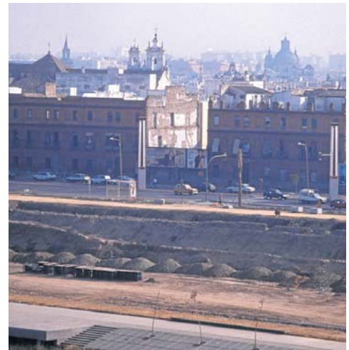
El derribo del muro de Torneo conectó la ciudad con el río. / E.C.
