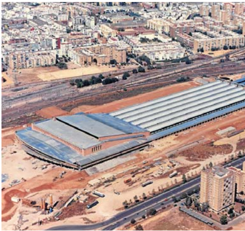
Distintas fases de la construcción de la estación ferroviaria de Santa Justa. / El Correo
