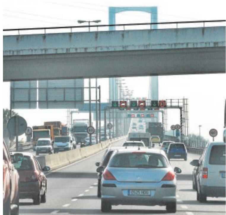
La propuesta recomienda semáforos para regular la entrada al puente
