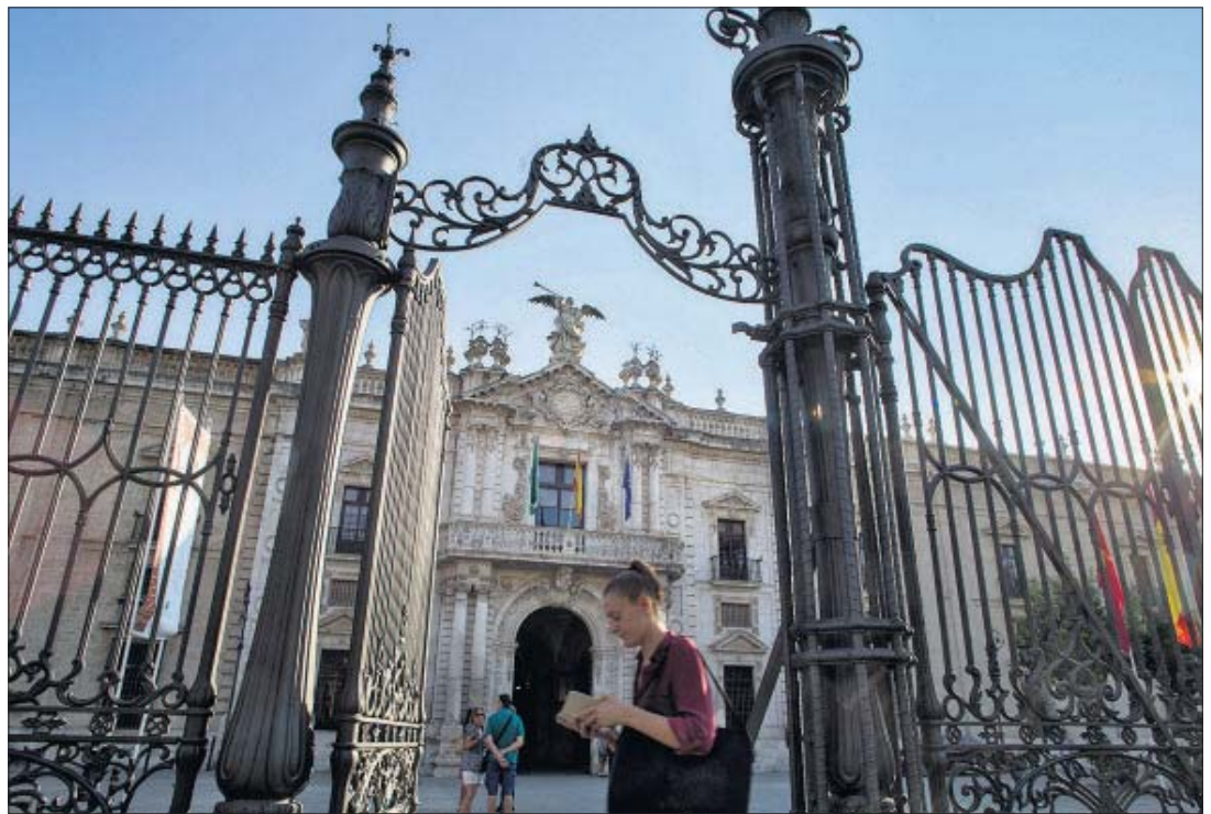
Fachada principal del Rectorado de la Universidad de Sevilla, la antigua Fábrica de Tabacos.
