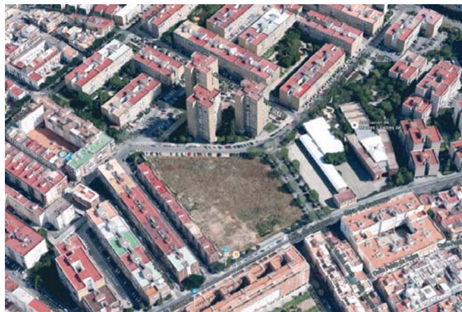
La parcela, completamente abandonada, en la que podrían levantarse tres edificios. GOOGLE MAPS
