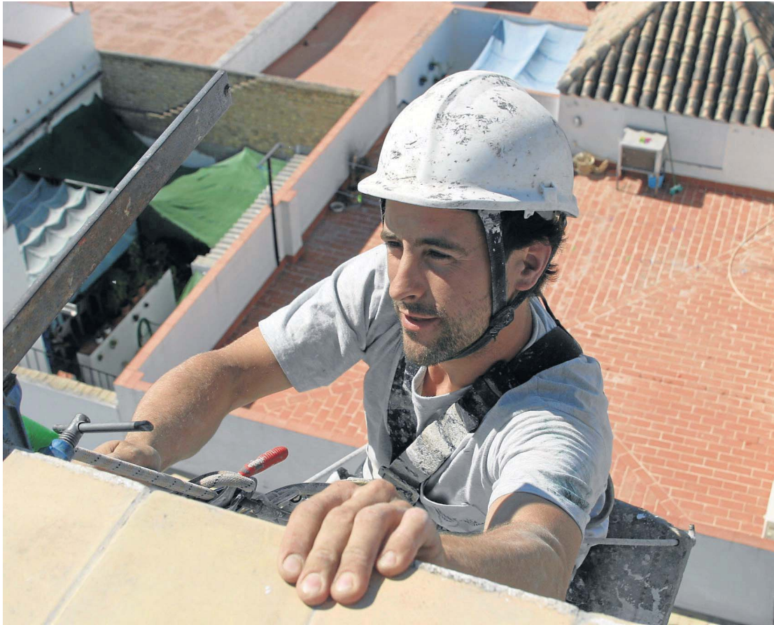
Un trabajador se cuelga de una azotea para pintar la fachada de un edificio en pleno verano. / Gregorio Barrera
