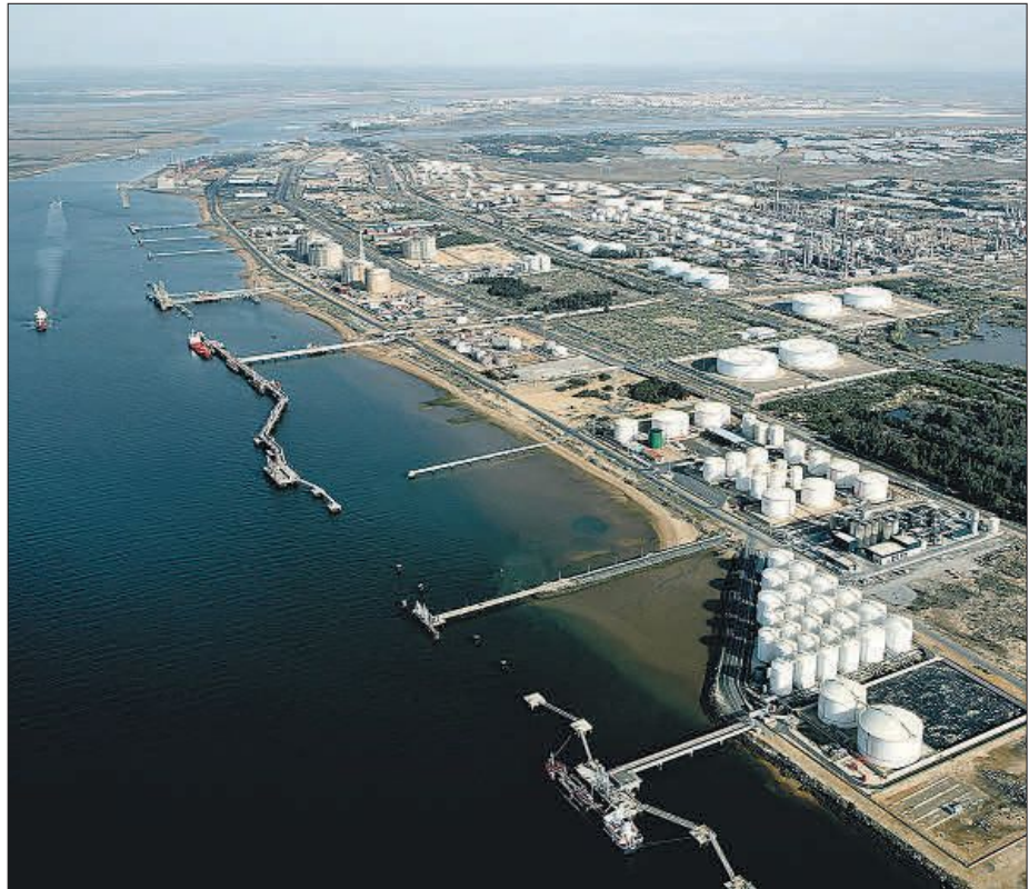
Vista aérea de la refinería de Huelva. EE
