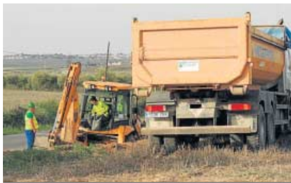
Las obras del carril bici, en una imagen reciente.
