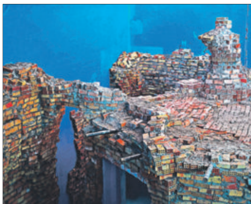
SITUACIÓN. Construcción de roca para uno de los rincones donde se ultiman las obras del Acuario de Sevilla.
