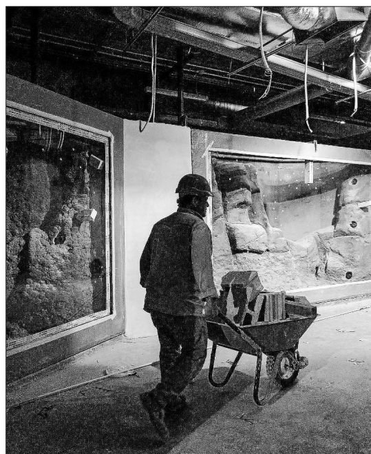
Las obras del acuario están al 85%, según Aquagestión. / JOSÉ LUIS MONTERO
