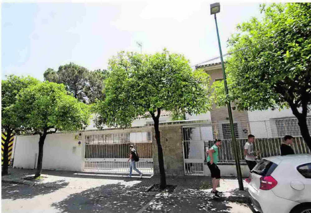
Rya construirá una residencia universitaria con 224 camas en la calle Tramontana, en Reina Mercedes JUAN FLORES
