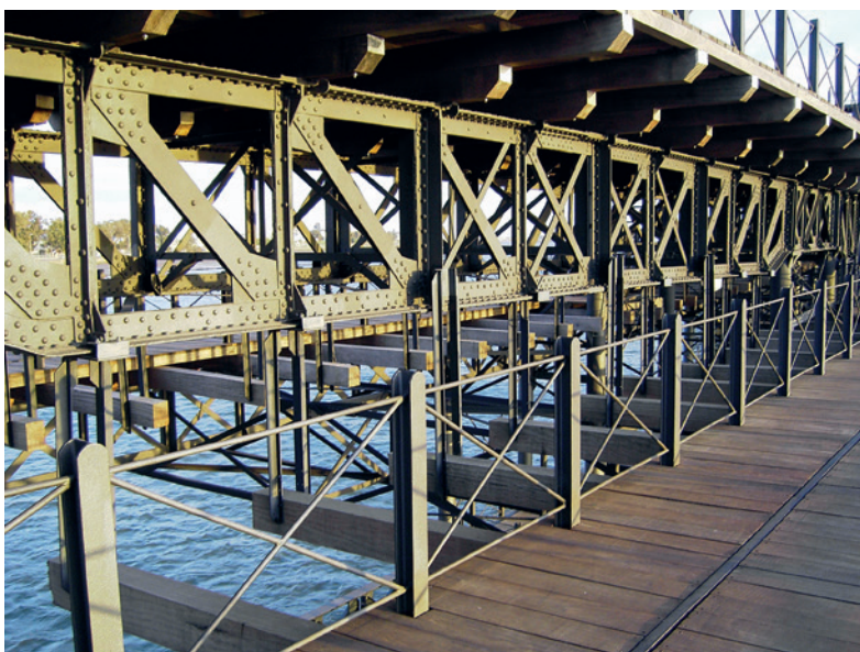
Figura 27. Muelle de carga de mineral de la compañía Riotinto. Arriba: antes de su rehabilitación en 1992. Abajo: después de ella
