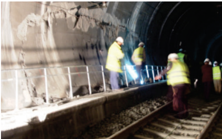
g) Estudio de rotura en un túnel ferroviario
